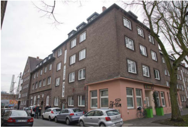
Heutiges Gebäude Dammstraße 21 – 25 mit Eckgebäude Friedrich-Ebert-Straße, damals Eingang in das sog. Verkehrslokal der Gewerkschaften ‚Zum Felsen‘ (zu dieser Zeit hieß die Friedrich-Ebert-Straße noch Industriestraße, zwischen 1939 und 1945 Kirdorf-Straße, benannt nach einem Industriellen und Förderer der NSDAP und Adolf Hitlers, ab 1945 dann Friedrich-Ebert-Straße)
