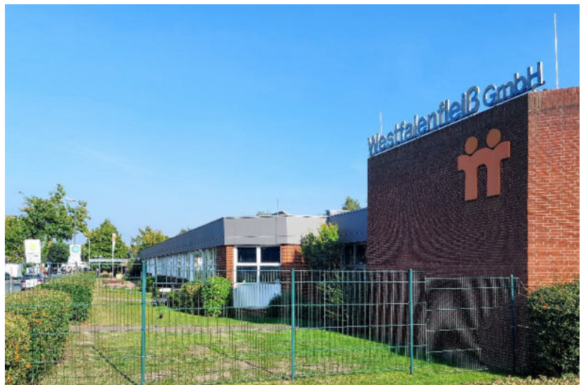
Werkstattgebäude der Westfalenfleiß GmbH am Kesslerweg 38-42
